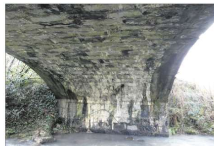
Intradós de la bóveda del puente pétreo del barrio de Riolangos (al norte del municipio de San Pedro del Romeral) sobre el río Aldano.
