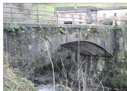
El puente sobre el río Yera en Vega de Pas fue reconstruido, después de su destrucción en 1937 durante la guerra civil, con bóveda de hormigón sobre los estribos pétreos primigenios.
