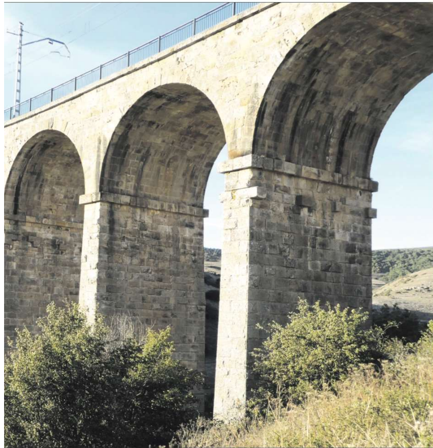
Detalle del viaducto ferroviario de Celada Marlantes. A la derecha, arriba, puente ferroviario de mediados del siglo XIX, con bóvedas pétreas, sobre el río Izarilla en Matamorosa. A la derecha, detalle de la bóveda. Debajo, puente de la línea de ferrocarril sobre el río Híjar entre Matamorosa y Reinoso. Sus pilas, de fábrica pétreo, son de 1857 y su tablero, con vigas de hormigón armado, es de 1942. / LVC
