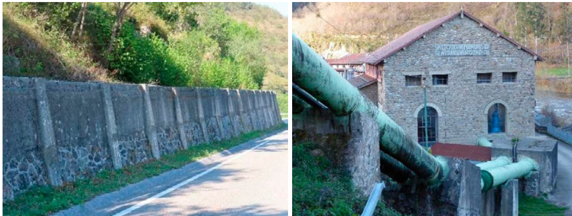
Figuras 3 y 4: Tramo del canal de Saltos del Nansa al norte de Santotís, entre las centrales de Bejo y Rozadío (LVC, 2025). Central de Rozadío (LVC, 2023).
