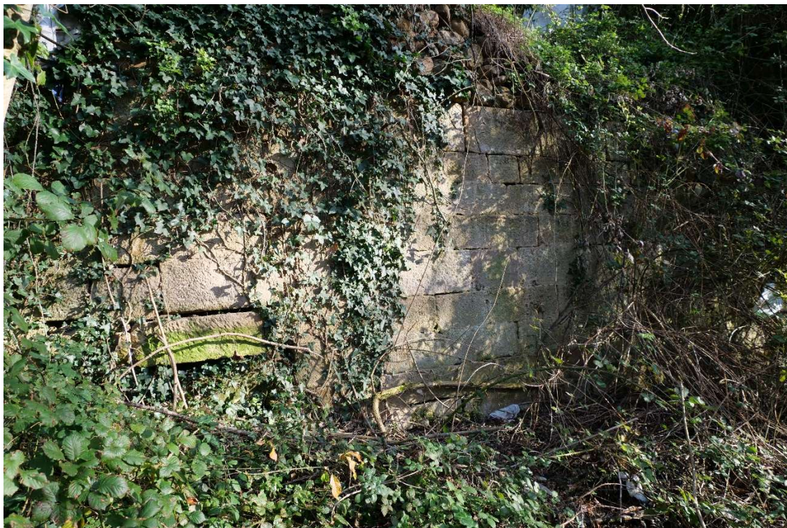
Figura 13. Muro de sillaría del estribo derecho del puente antiguo (V. Cassi).
