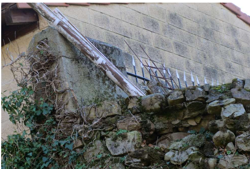
Figura 11. Murete del pretil y en su frente se aprecia el mechinal donde apoyaba la barandilla de madera del puente (V. Cassi).
