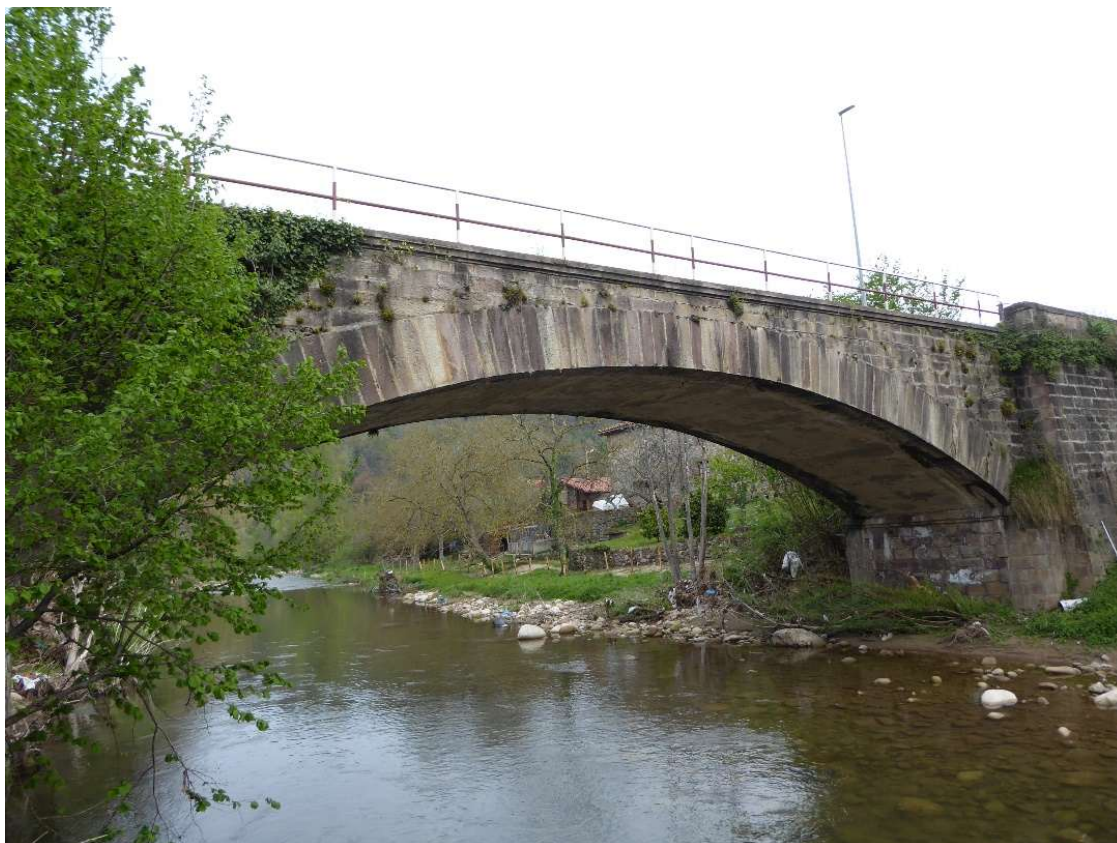
Figura 18. Bóveda principal del puente actual de Arenas de Iguña sobre el río Besaya (LVC).
