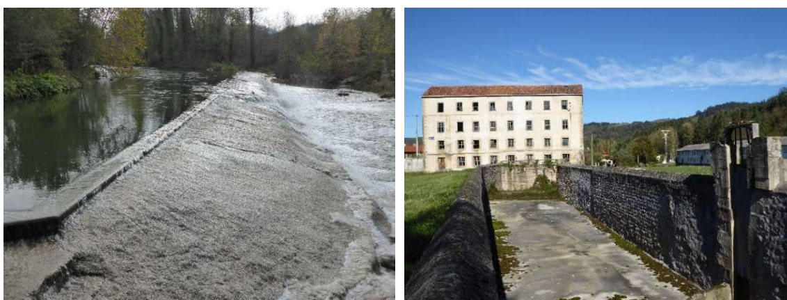
Figuras 11 y 12: Azud sobre el río Besaya de la antigua ferrería Las Bárcenas de San Felices de Buelna (LVC). Edificio y embalse de carga de la antigua fábrica harinera de La Herrán (LVC).
