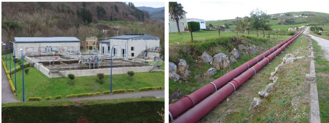
Figuras 9 y 10: Estación de depuración de aguas residuales (EDAR) de Las Fraguas: vista general (LVC). Tuberías de la EDARI de Solvay que transportan aguas depuradas al emisario submarino de la playa de Usgo - Miengo (LVC).
