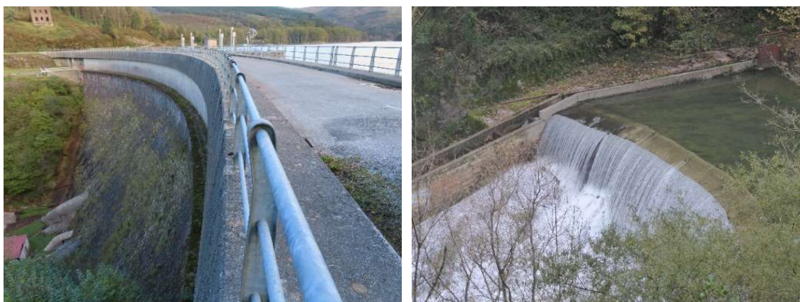
Figuras 13 y 14: Presa de Alsa de la Central Hidroeléctrica de Torina - Bárcena de Pie de Concha (LVC). Presa, con su escala de peces, de la antigua fábrica de La Emiliana en Riocorvo – Cartes (LVC).
