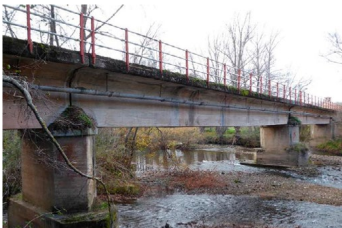
Puente de hormigón armado sobre el río Ebro en La Puente del Valle (LVC)
