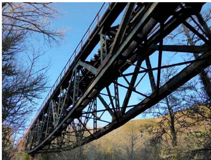
Puente del FC de La Robla sobre el río Ebro cerca de Arroyo en Las Rozas de Valdearroyo (LVC).
