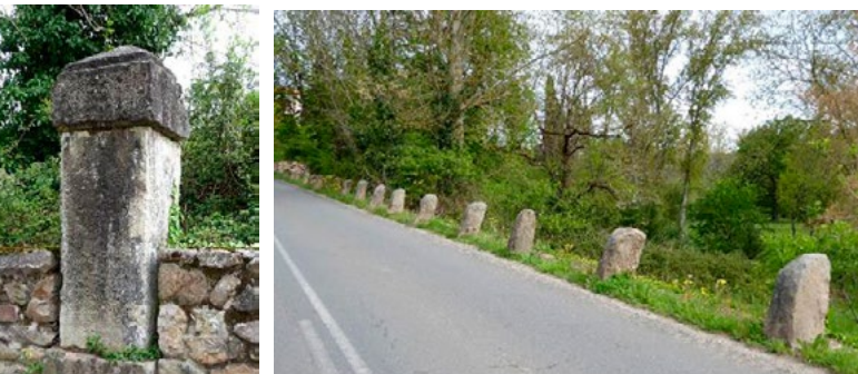
Hitos pétreos del camino real a su paso por el valle de Iguña: Leguario en Las Fraguas y guardarruedas al sur de Molledo (LVC).
