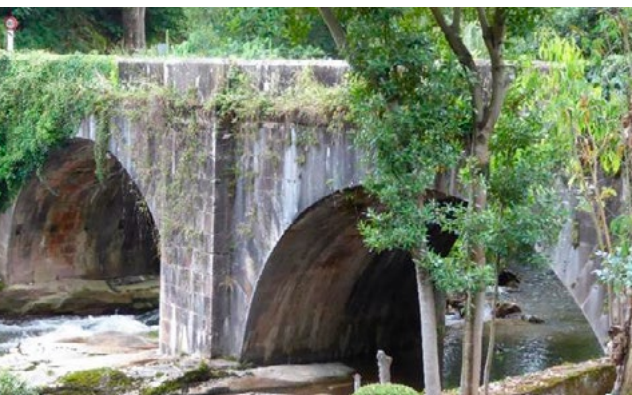
Puente del camino real en Santa Olalla (estrecho de Portolín) sobre el río Besaya (LVC).
