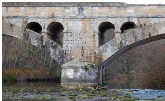
Puente de Báscones de Ebro (Berzosilla – Palencia) sobre el río Ebro: Obra de hormigón y de cantería de los años 40 del siglo XX (LVC).
