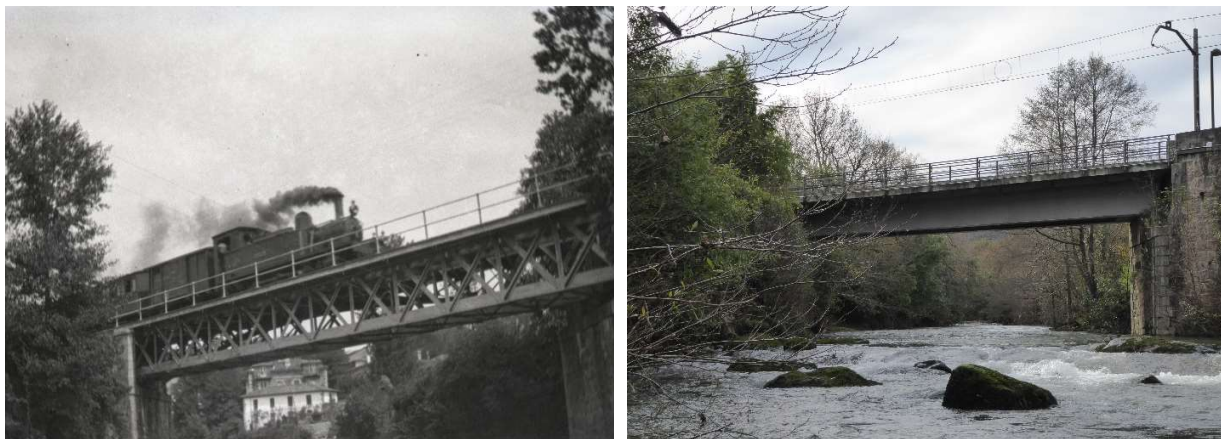
Puentes metálicos sobre el río Miera en La Cavada – Ferrocarril entre Orejo-Solares y Liérganes: el primigenio y el actual, de principios y finales del siglo XX (A. Faci 1917, cortesía de C. Losada, y LVC).
