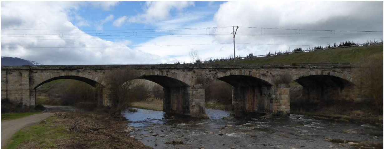
Puente ferroviario de mediados del siglo XIX, con bóvedas pétreas esviadas, sobre el río Izarilla en Matamorosa (LVC).
