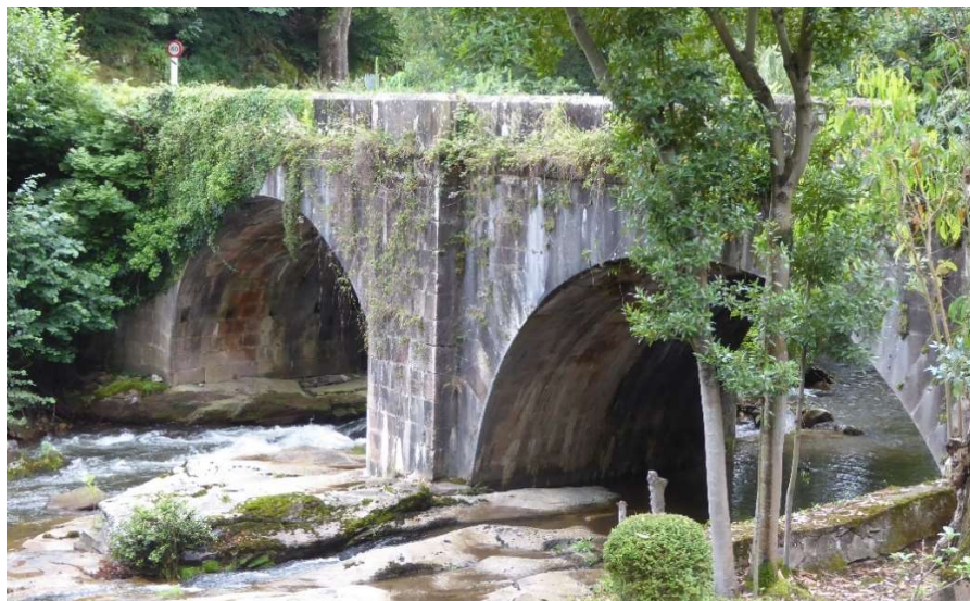
Puente del camino real en Santa Olalla (estrecho de Portolín) sobre el río Besaya (LVC).
