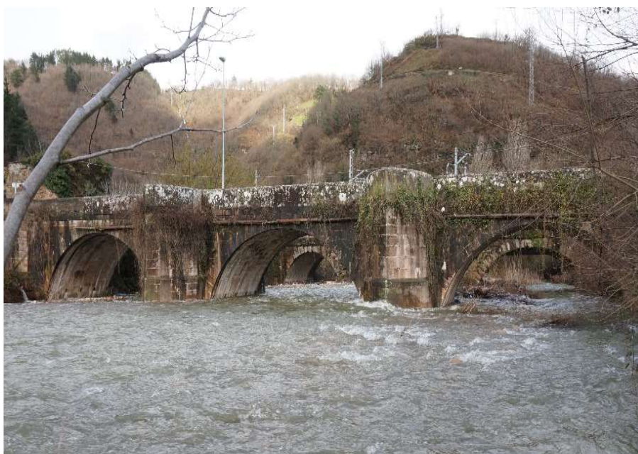
Puente del camino real de Santander a Reinosa sobre el río Los Llares en Las Fraguas (LVC).
