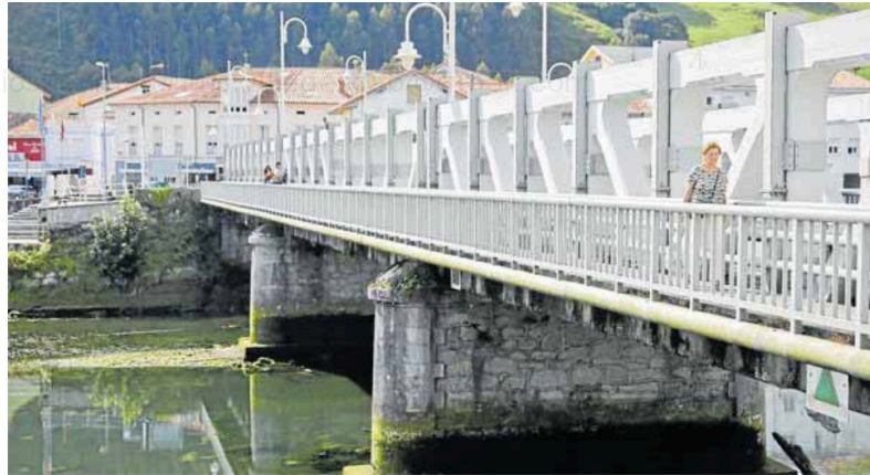
Puente de hormigón armado entre Unquera y Bustio. JUANJO SANTAMARÍA
