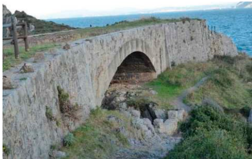
Figuras 13 y 14: El cargadero exterior de la ensenada de Urdiales ubicado en la Punta de la Pepina (blog fotos antiguas de Castro Urdiales – Paco Ureta). Puente de Punta de la Pepina de acceso al cargadero anterior en la actualidad (LVC).
