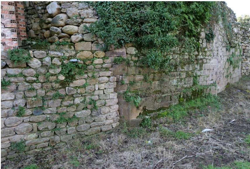
Figura 10. Se ve el frente del estribo izquierdo y los dos muros laterales que acuerdan oblicuamente con él (foto de Víctor. Cassi).
