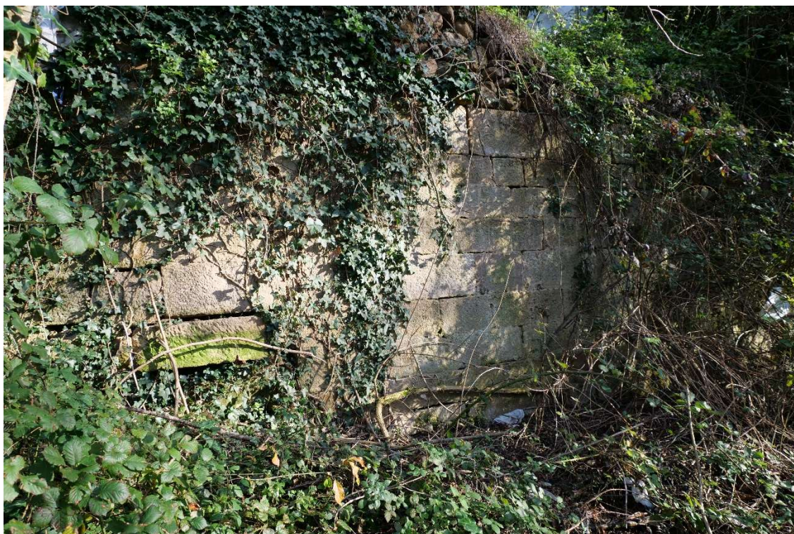
Figura 13. Muro de sillería del estribo derecho del puente antiguo (V. Cassi).
