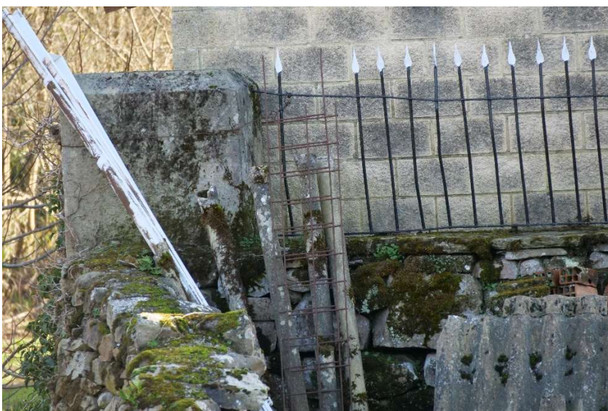
Figura 12. Murete del pretil y verja de hierro que marca el borde del camino de acceso al puente (V. Cassi).
