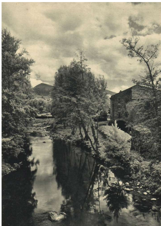
Figura 7. El río Besaya a su paso por Arenas de Iguña. La imagen está tomada desde el puente nuevo. Al fondo de la misma puede verse la presa desde la cual se derivaba agua al molino que aparece a la derecha de la foto. Delante del edificio aparece el estribo izquierdo del puente decimonónico (De Tomás Quintana - SAMOT- y Alejandro Quintana en “Lo admirable de Santander”, 1935.
