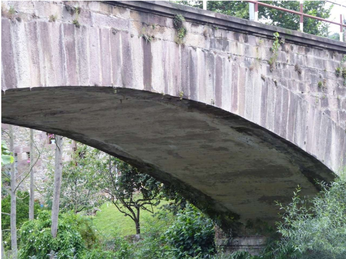
Figura 19. La bóveda principal del puente de Arenas, destruida durante la Guerra Civil, fue reconstruida con hormigón y su fachada se hizo con piedra para conservar la estética de la estructura global (LVC).
