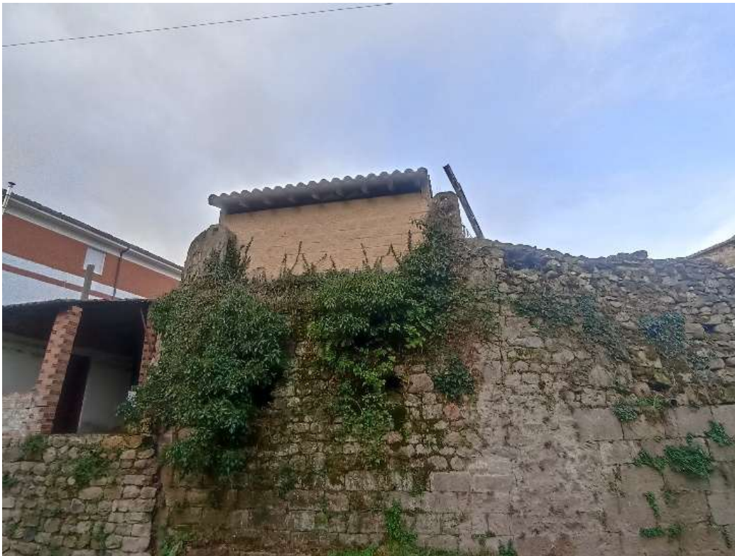
Figura 8. Alzado del estribo izquierdo del puente antiguo, en su parte superior se ve una caseta construida sobre el acceso al paso y dos muretes de piedra donde apoyaba la baranda de protección del puente sobre el río (foto de Cruz Pardo).
