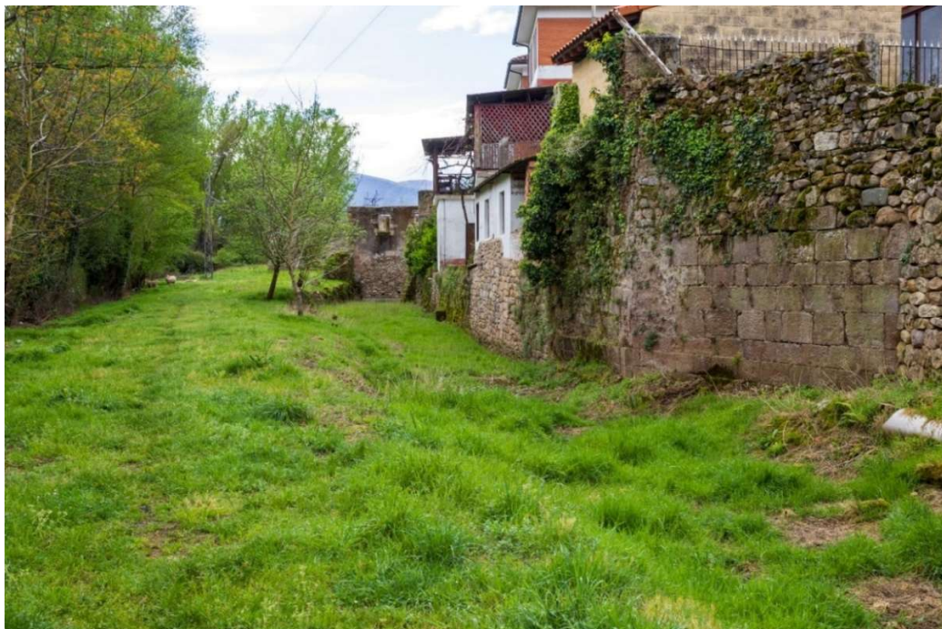
Figura 9. Muros, entre ellos el estribo izquierdo, que canalizan las aguas del Besaya en caso de avenidas. Se aprecia el socaz del molino y al fondo el arco cegado de su cárcavo (foto de Lino Mantecón Callejo).
