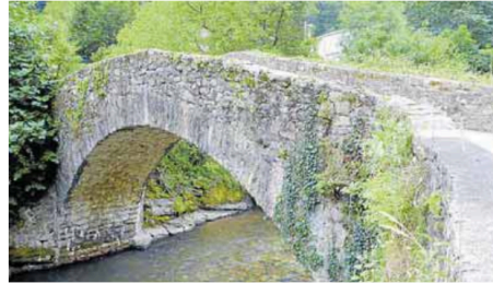
Puente, en Rozadío (Rionansa), sobre el río Nansa.
