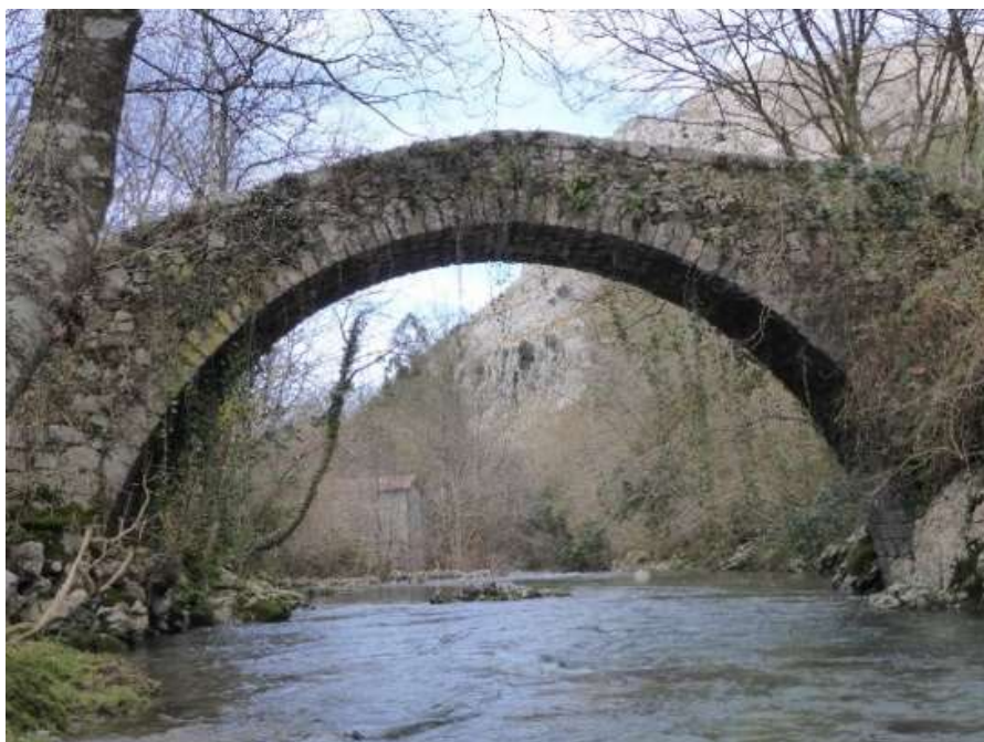
Puente sobre el río Miera en Mirones (LVC)
