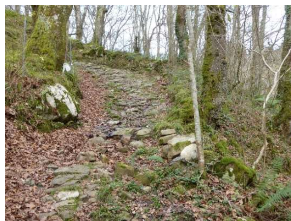
Vista del pavimento encachado y pretilos del puente de Linto y tramo empedrado del camino entre Linto y La Cárcoba de Miera (LVC).
