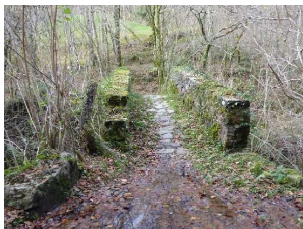
Vista del pavimento encachado y pretilos del puente de Linto y tramo empedrado del camino entre Linto y La Cárcoba de Miera (LVC).
