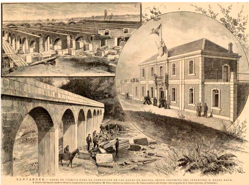
Figura 1: La traída de aguas a Santander en la Ilustración Española y Americana del 22 de enero de 1885: estructura del depósito y oficinas en Pronillo y el acueducto de Villasevil de Toranzo (Colección R. Villegas).
