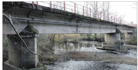
A la izquierda y arriba, imágenes del puente de Báscones de Ebro (Berzosilla-Palencia) sobre el río Ebro, obra de hormigón y de cantería de los años 40 del siglo XX. A la derecha, detalle del puente de Quintanilla de An que muestra el apoyo de sus dos vigas en la pila central, y, debajo de estas líneas, vista general de la infraestructura construida con hormigón armado. / LVC
