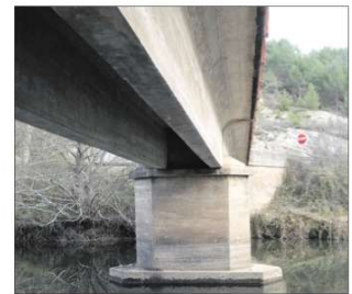
A la izquierda y arriba, imágenes del puente de Báscones de Ebro (Berzosilla-Palencia) sobre el río Ebro, obra de hormigón y de cantería de los años 40 del siglo XX. A la derecha, detalle del puente de Quintanilla de An que muestra el apoyo de sus dos vigas en la pila central, y, debajo de estas líneas, vista general de la infraestructura construida con hormigón armado. / LVC
