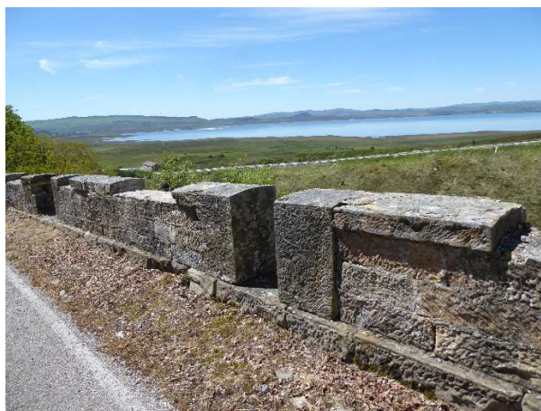
Testigos pétreos en la carretera de Peñas Pardas a Selaya: miriámetro de su kilómetro 10 y coronación de un muro de contención cerca de su enlace con la carretera de Burgos a Santander (LVC).
